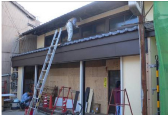
1階、2階ともに壁が新設され、幕板とシャッターボックスにアルミパネルが張られた。
