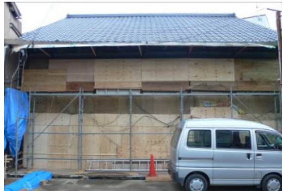
二階部分の窓のサッシを新設するため、既存部分が撤去された。
