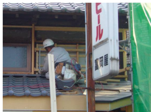
小庇の道路側の部分には瓦は数かず写真のように金属張りとしている。
