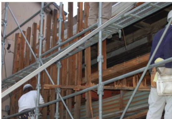
パラベットが取り付けられていた構造の確認
