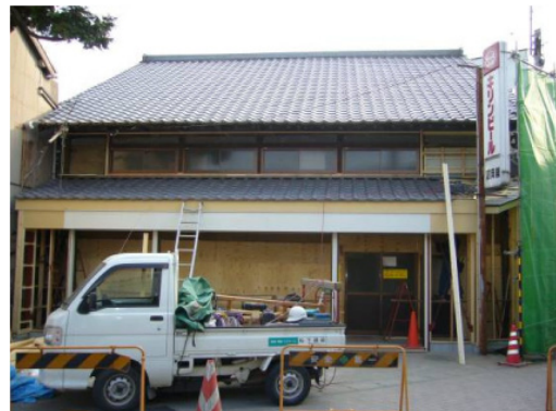
小庇に瓦が葺かれ2階の窓も新設された。
