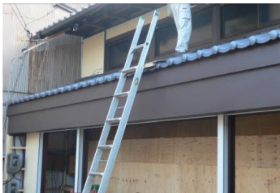
小庇の下が幕板とシャッターボックス。2階部分は写真の意の手前に、さらに格子と以前使用していた意を加工したものが取り付けられる。
