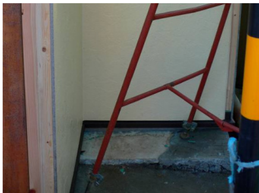
1階道路側の壁面。小庇と同様道路境界線を考慮し一段鉤型になっている。まだ耐火サイディングによって装飾が施されていない状態。
