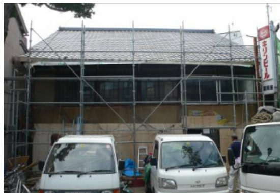
パラベットと以前の改装によって取り付けられた構造体が全て撤去された。 隠れていた二階壁面部分が全て見えるようになった。
