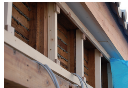
パラペット撤去後の処理
