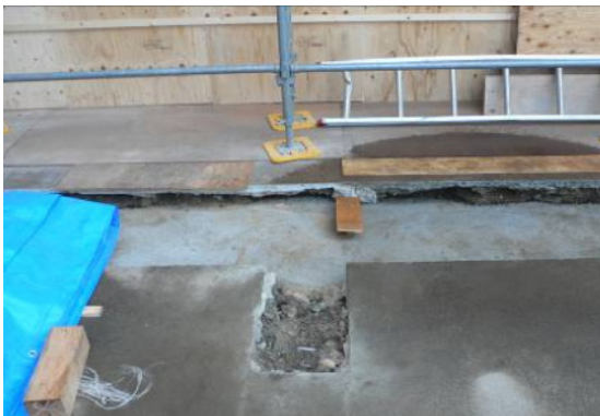
店舗前面部分の構造を新たに作るため、その基礎部分にコンクリートを打つ。
