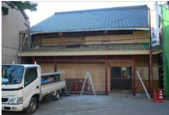
養生の済んだ基礎の上に1階店舗部分の鉄骨が建てられ、小庇も取り付けられた。
