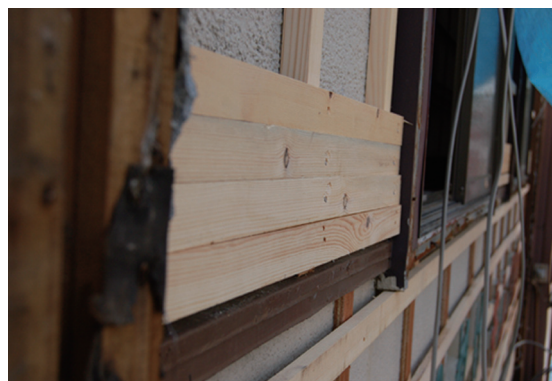
既存ファサードに新しいファサードの胴縁、下地材を取り付ける
