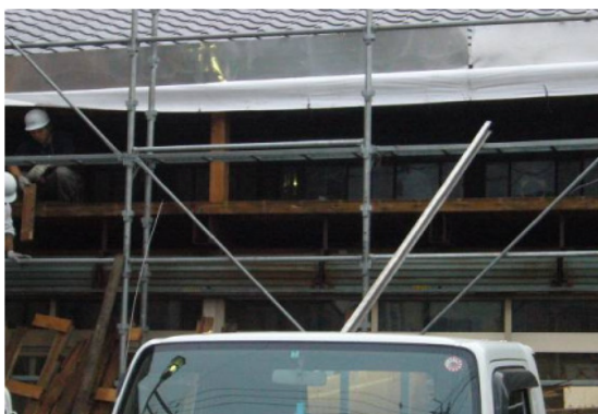
昔の壁面が出て以前使用されていたガラス窓の上部が見える。 以前の改装による店舗増築部分は天井高が既存の建物より高いため、 二階部分の窓の下部は隠れている。
