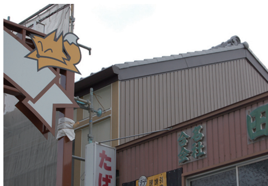
反対側の側面の外壁も張り替えられた
