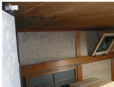
(A3) 図 3.4 天井雨漏りのしみ
