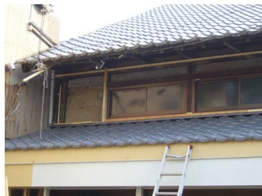
新設された窓は小庇の位置も考慮し、以前の窓の半分程度の高さとなっている。
