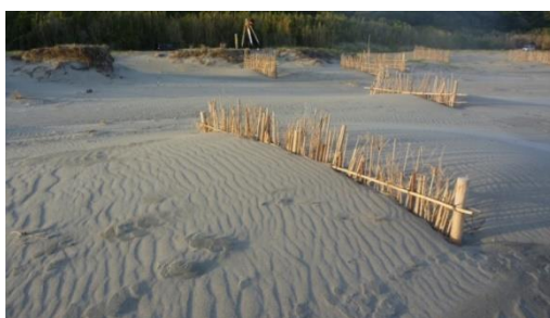
写真 4.2 堆砂堰による養浜 (2010年4月21日撮影)
