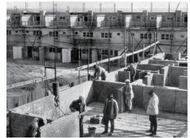
図2.7 ジードルンク建設にプレファブリケーションが用いられた様子
