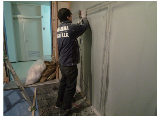
図 5.52 改修工事中 学生による壁面の平滑処理
