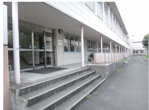
図 6.32 都市・環境工学科棟
