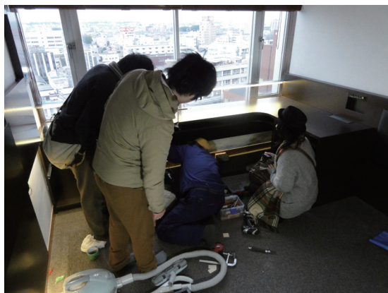
図 6.18 業者の作業を見学する学生
