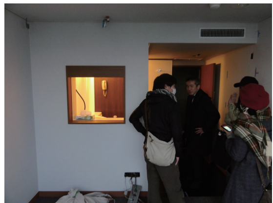
図 6.19 改修中の現場を確認する学生・担当教員
