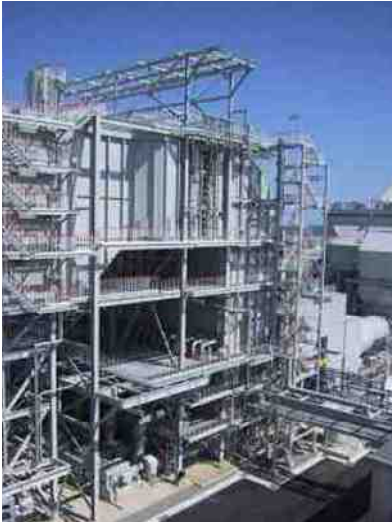
図 1.1 排煙脱硫装置
