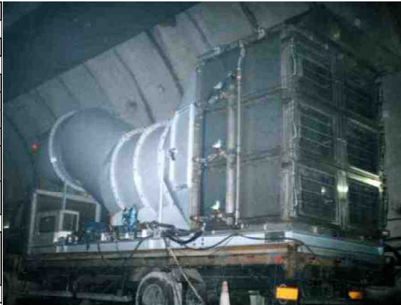
図 1.2.3(a) 掘削工用電気集塵装置
