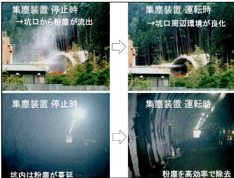
図 1.2.3(b) 掘削工用電気集塵装置の効果 (その 1)
