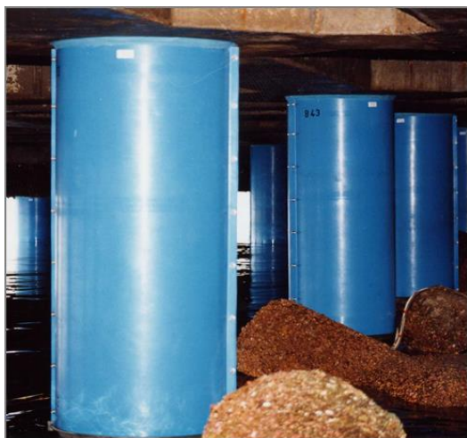
写真 4.1 ペトラタム被覆防食工法の主材料として用いられているFRP (写真中の青い保護カバーがFRP)
