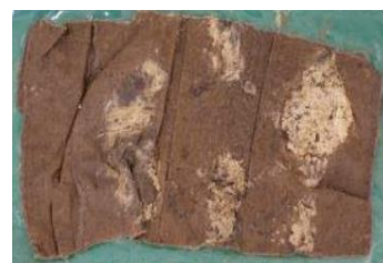
10年暴露試験体 (陸側)
