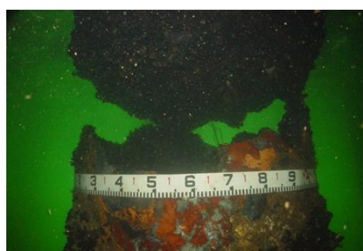
(b) 鋼管杭の欠損 (杭全体が腐食によって欠損)
