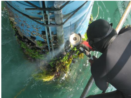
(a) FRP切断除去状況
