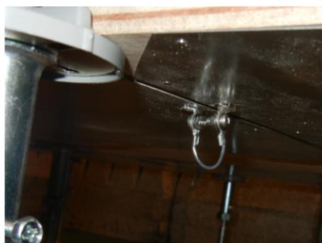
図 3.18 亜鉛板の接続
