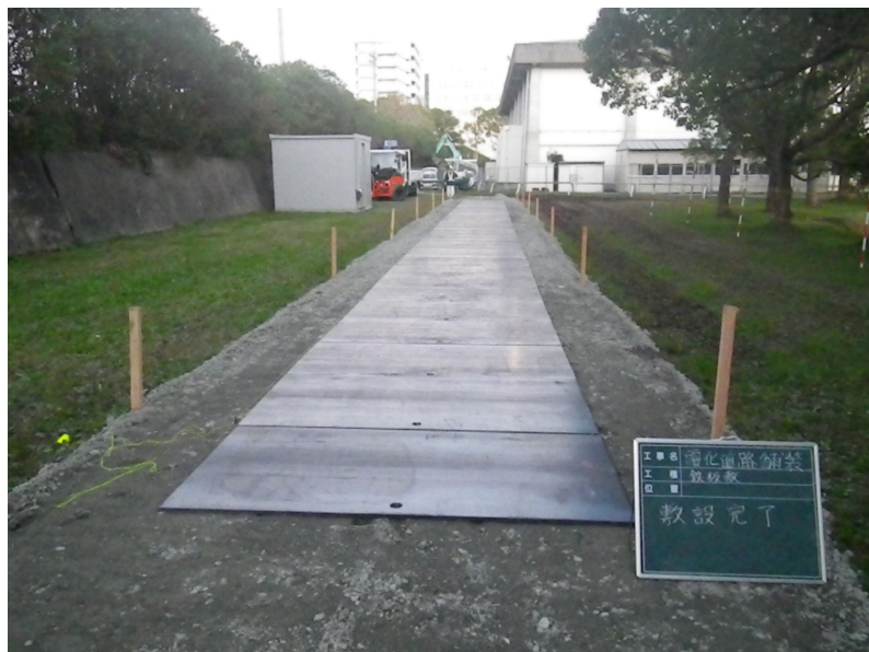
図 5.31 グランド板施工
