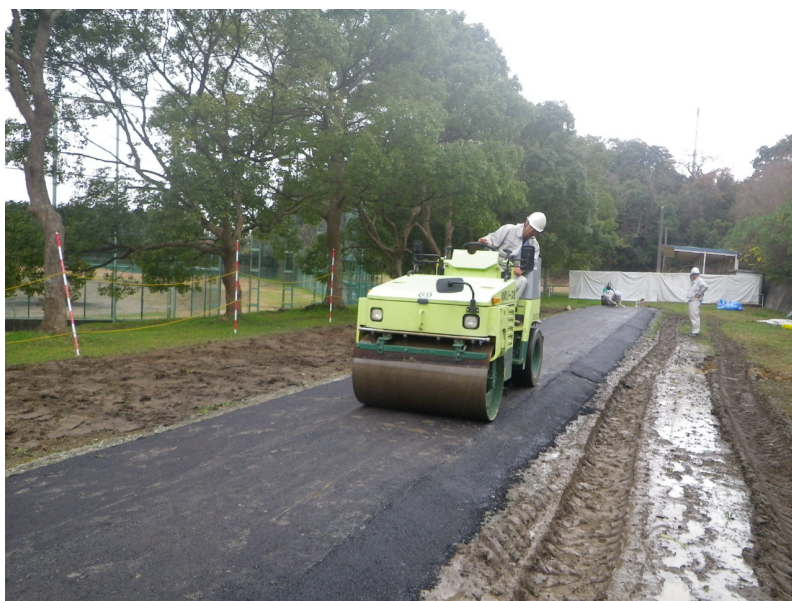
図 5.34 特殊アスファルトによる表層施工
