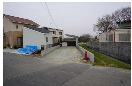
写真 5-11 新規居住者地区（新規建設）
