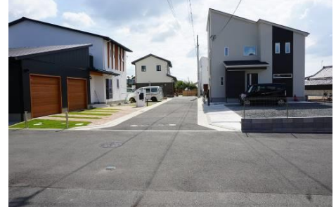
写真5-8 新規居住者の住宅建設(2017.9)
