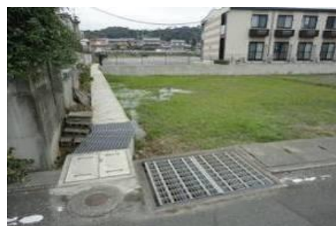
写真 4-3 上宿地区内の道路（左(A)：変則交差点 右(B)：排水不良）
