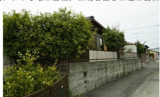
写真 5-3 新規居住者地区(空き家)住宅
