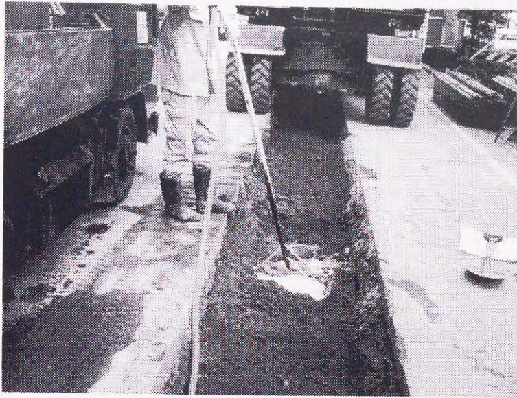
写真-7.3 活性剤水溶液の散布の様子
